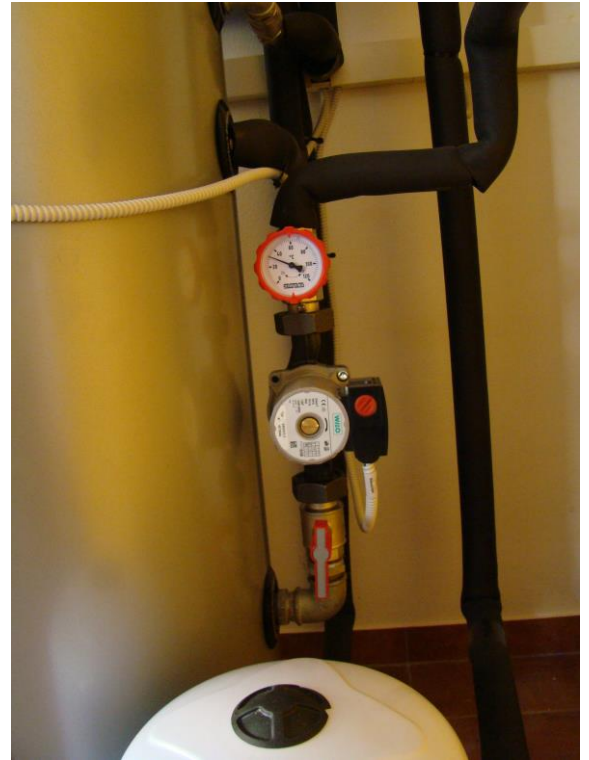
Sklop za ogrevanje bojlerja STV
