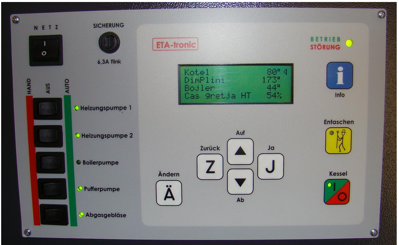
Upravljalni pano kotla ETA SH
