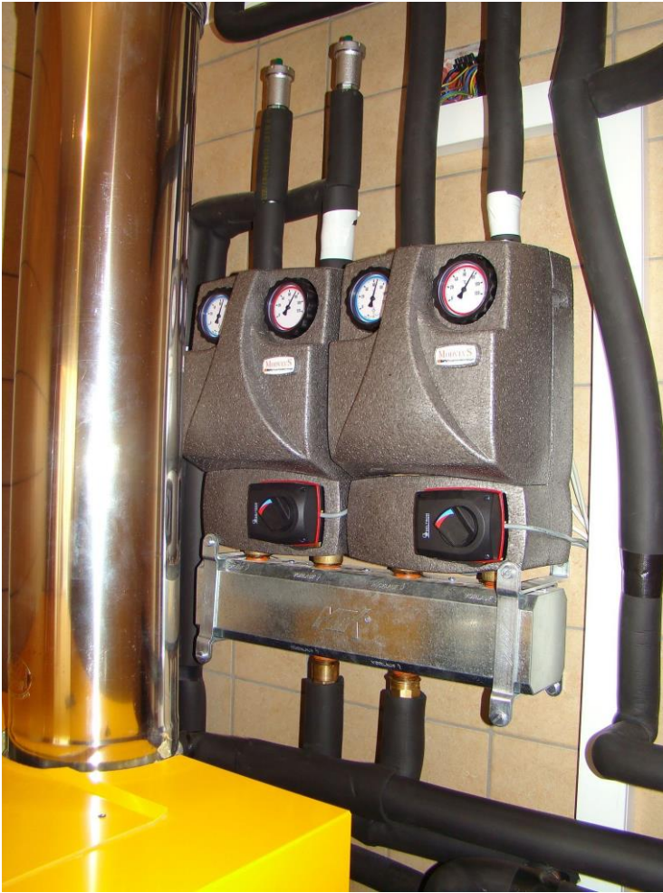
Upravljalni pano kotla ETA SH
