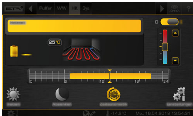
Sl. 5-89: Talno gretje brez sobnega termostata
