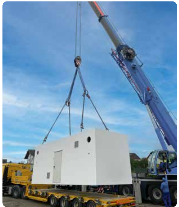
Anlieferung mittels Spezial- oder Tiefladerfahrzeug
